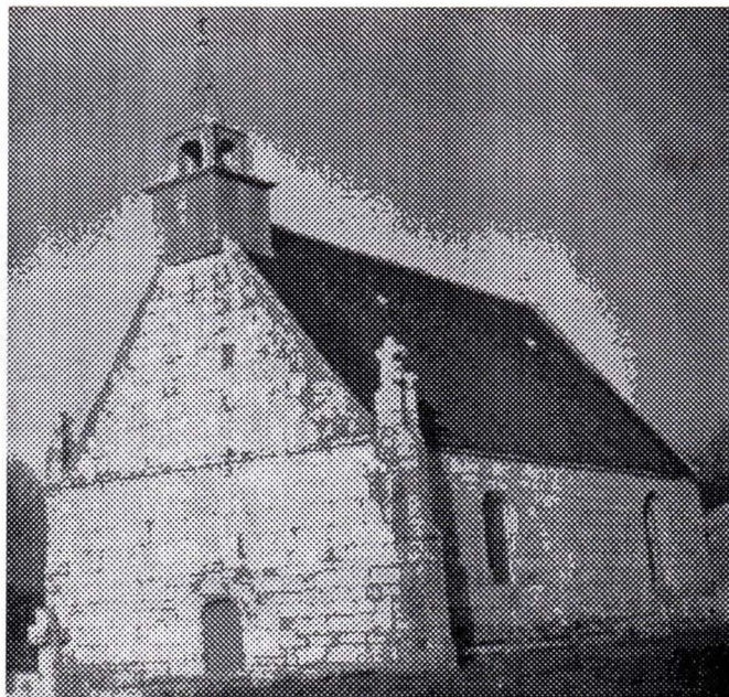
La chapelle et le calvaire de Kergroix en Carnac, Morbihan Premier chantier de Breiz Santel, par Gérard Verdeau. 1954
