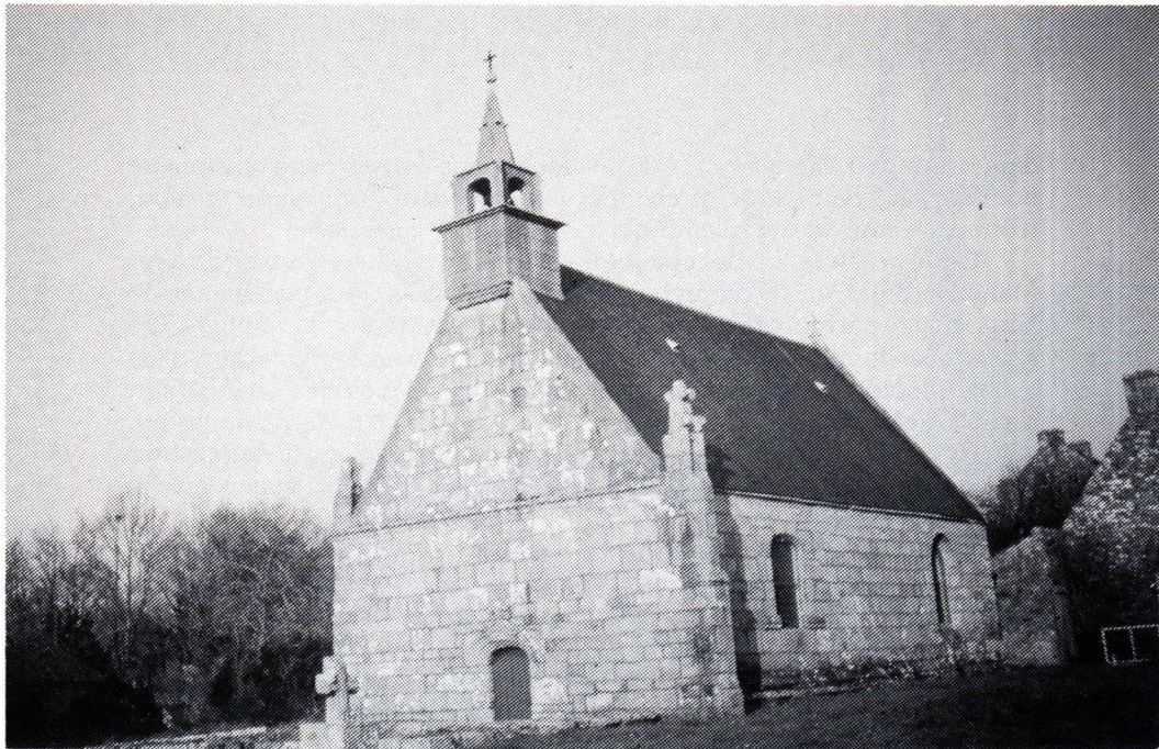
La chapelle et le calvaire de Kergroix en Carnac, Morbihan. Premier chantier de Breiz Santel, par Gérard Verdeau. 1954.
