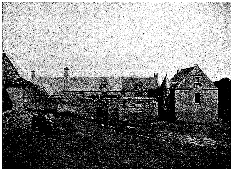
Cap Sizun : Château de Lesurec en Primelin (abandonné aux pourceaux).
