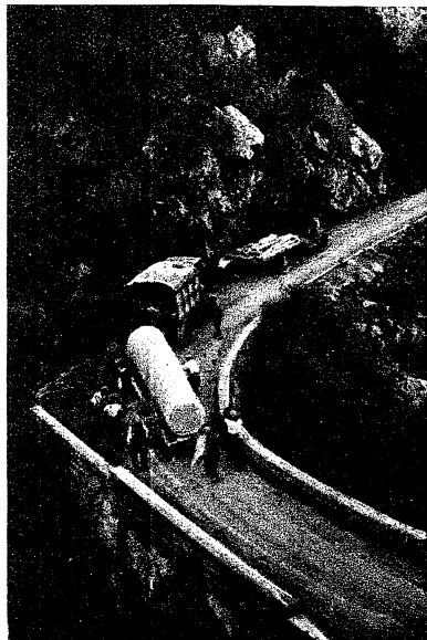
Transport d'une des grandes colonnes du Sacré-Cœur de Marseille.
