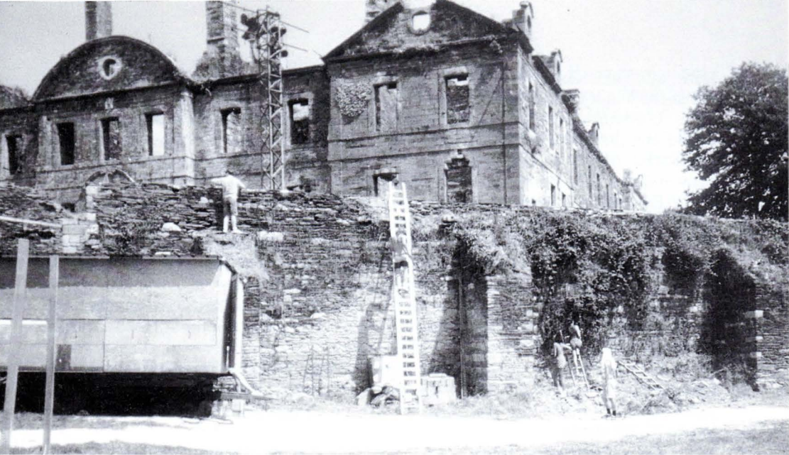
Abbaye de Bon-Repos à Saint-Gelven en Côtes-d'Armor. Désherbage des murs.
