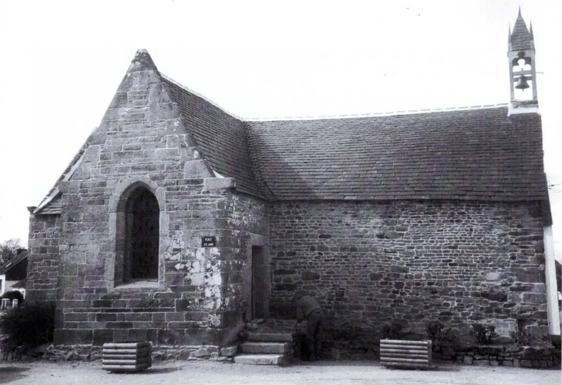
La chapelle Sainte-Anne à Trébrivan, en Côtes-d'Armor, le jour de la réception des travaux de maçonnerie, de la charpente et de la couverture.
