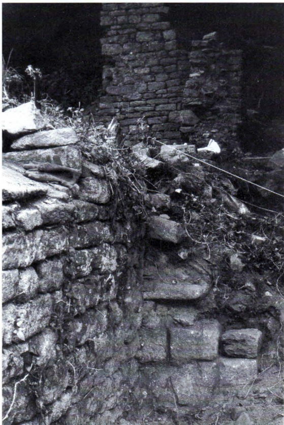
Contrefort extérieur qui soutenait l'arcade partant du clocher, à gauche de la fenêtre Sud-Est de la nef.
