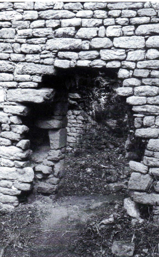
La porte Sud-est de la chapelle après son dégagement du lierre.
