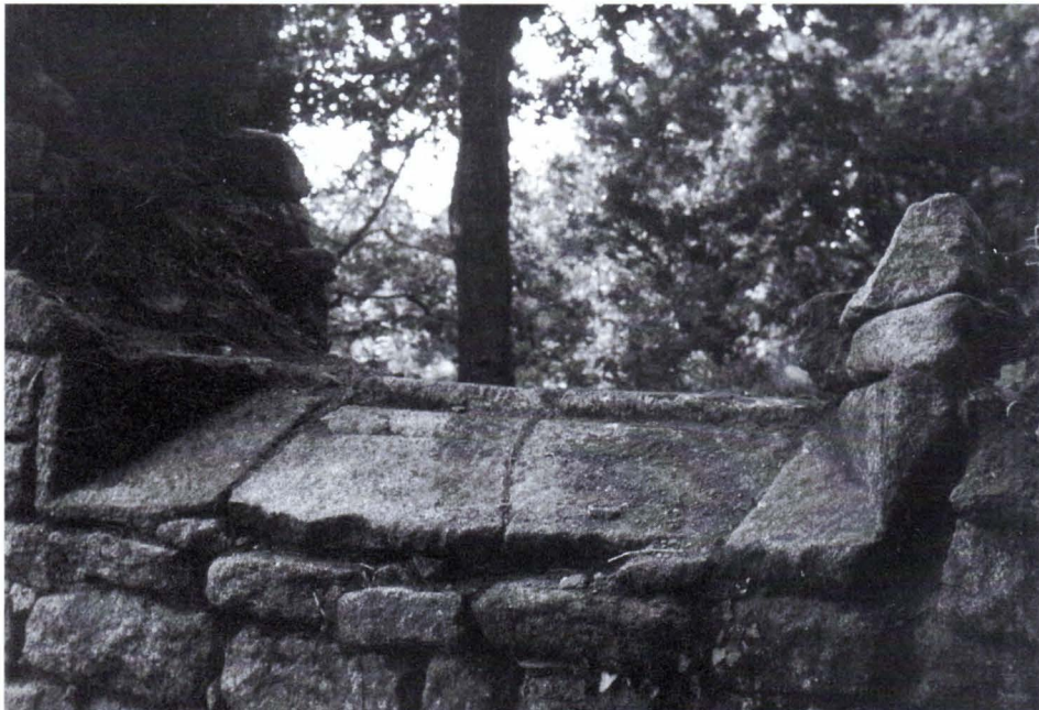
Soubassement de la fenêtre Sud de la nef en bon état de conservation.
