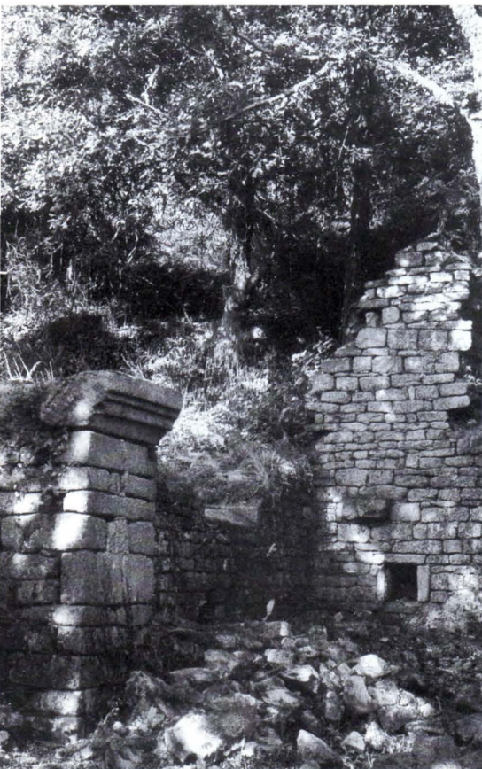
Pilier Nord séparant le chœur de la nef et sur lequel reposait l'arcade soutenant le clocher.
