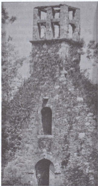
Le clocher en ruines avant les travaux.
