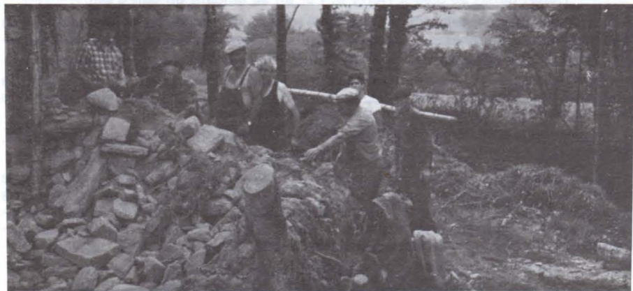
Un aspect du chantier cet été 1985 : le démontage du petit mur par une équipe de volontaires.
