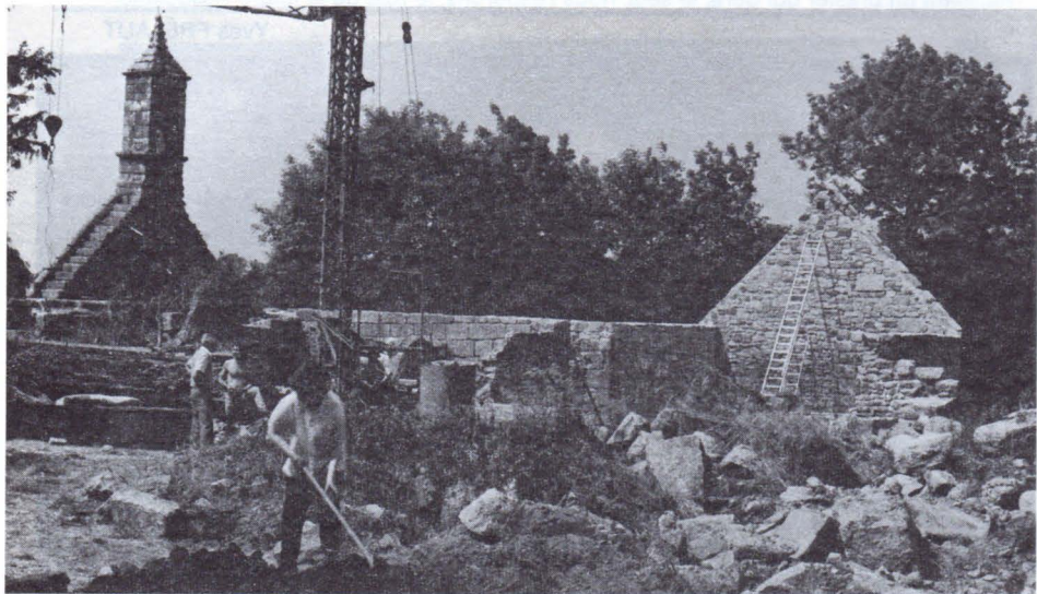
Le chantier de la chapelle du Loc'h au 15 juin 1988 (Photo Per Peron).
