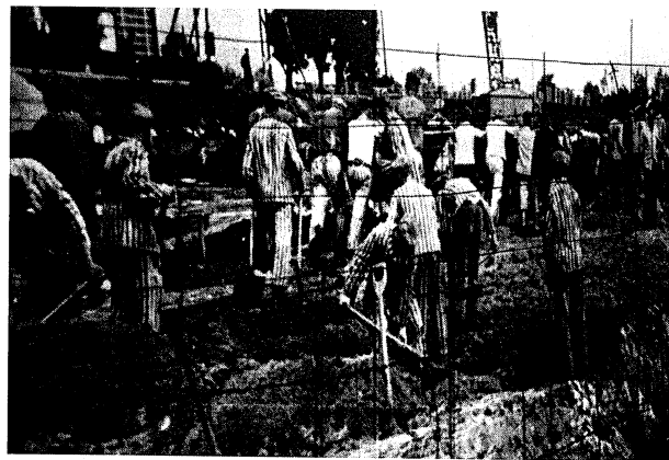
Terrassement de la Briqueterie
