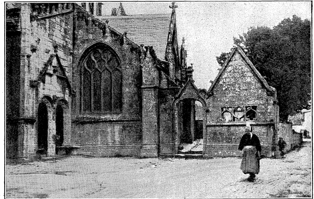
PENMARC'H. ⚡ Le centre communal, jadis ville importante, n'est plus qu'un simple bourg ; mais il a conservé la belle église Saint-Nonna, du style gothique flamboyant. On voit ici la porte en accolade de l'ancien cimetière, entre l'église elle-même et le pignon d'un ancien ossuaire. En avant, une femme coiffée du « bigouden ». (Cl. G. Monmarché.)
