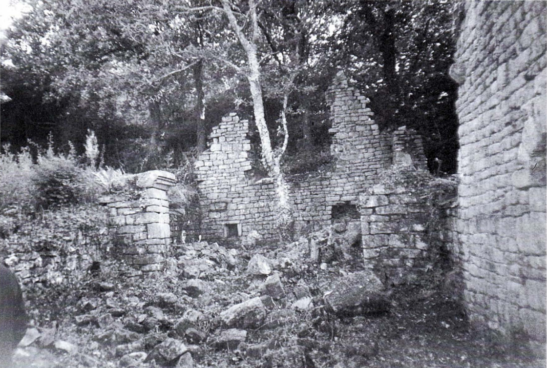
L'intérieur en ruines de la chapelle de Loquéran à Plouhinec, Finistère.
