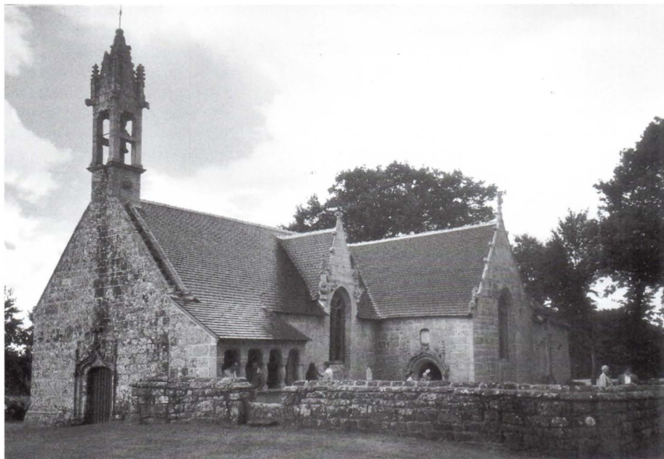
La chapelle Saint-Guen restaurée après l'incendie criminel.
