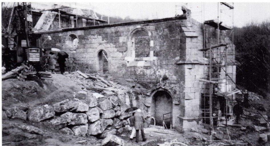
Visite de la chapelle de Trémeur en cours de restauration.
