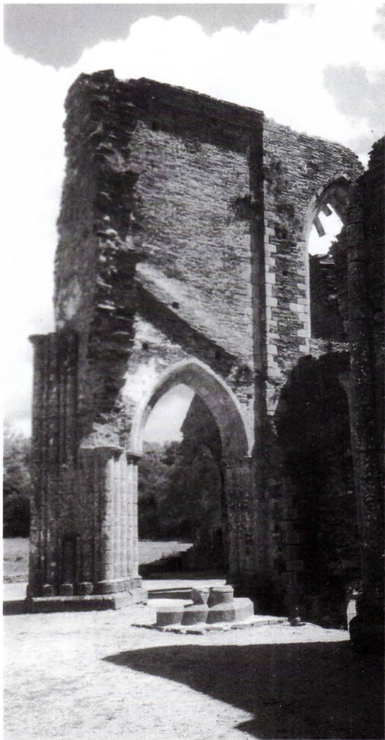
Ce qui reste de l'abbatiale Bon-Repos. Devant l'ogive, la reconstitution de la base d'un pilier.
