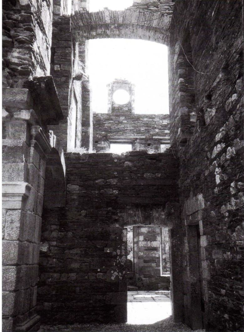
Abbaye de Bon-Repos. L'entrée de la première salle du bâtiment conventuel ; au-dessus, une fenêtre restaurée aux frais de Breiz Santel.
