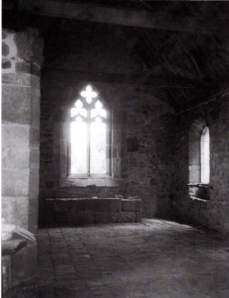
Saint-Laurent à Kervignac. Fenêtre du chevet, la fenêtre Sud et le dallage du chœur.
