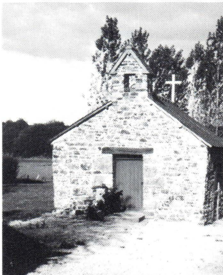
Ancienne bergerie devenue chapelle Notre-Dame de Consolation au lieu-dit « Les Parpareux ».
