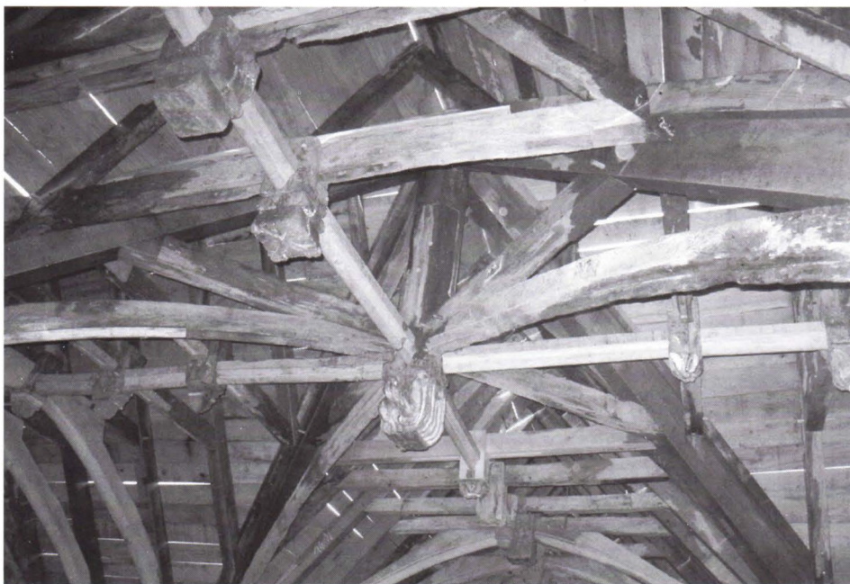
La charpente au-dessus du chœur.
