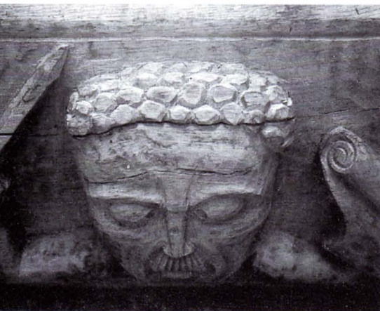
Détail d'une sablière.
