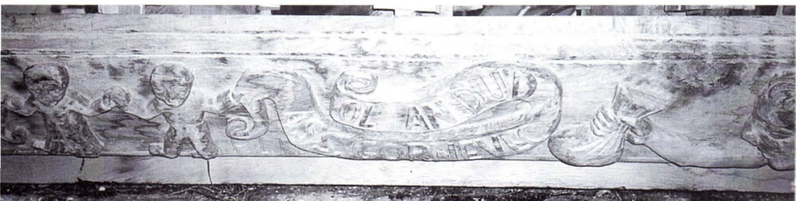
Dans la nef, détail d'une sablière.
