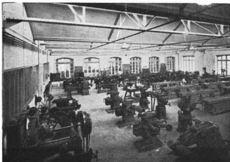
Le nouvel atelier de mécanique.
