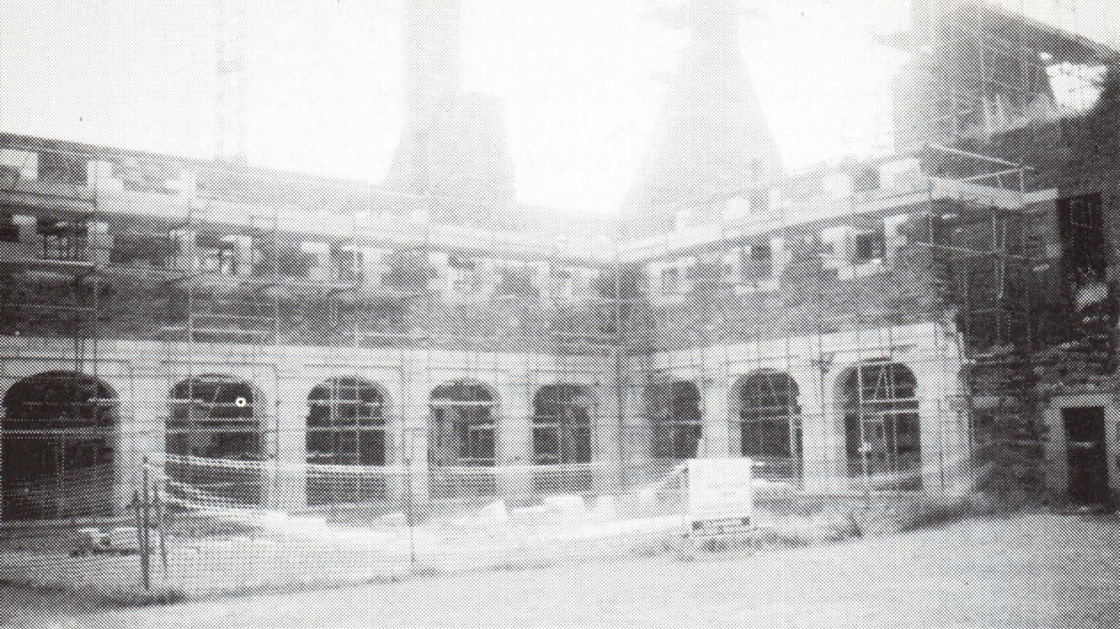
Juillet 1994, le cloître en restauration.
