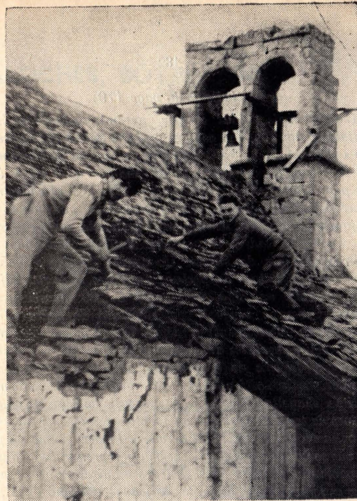
On démolit le versant nord du toit, irrécupérable.
